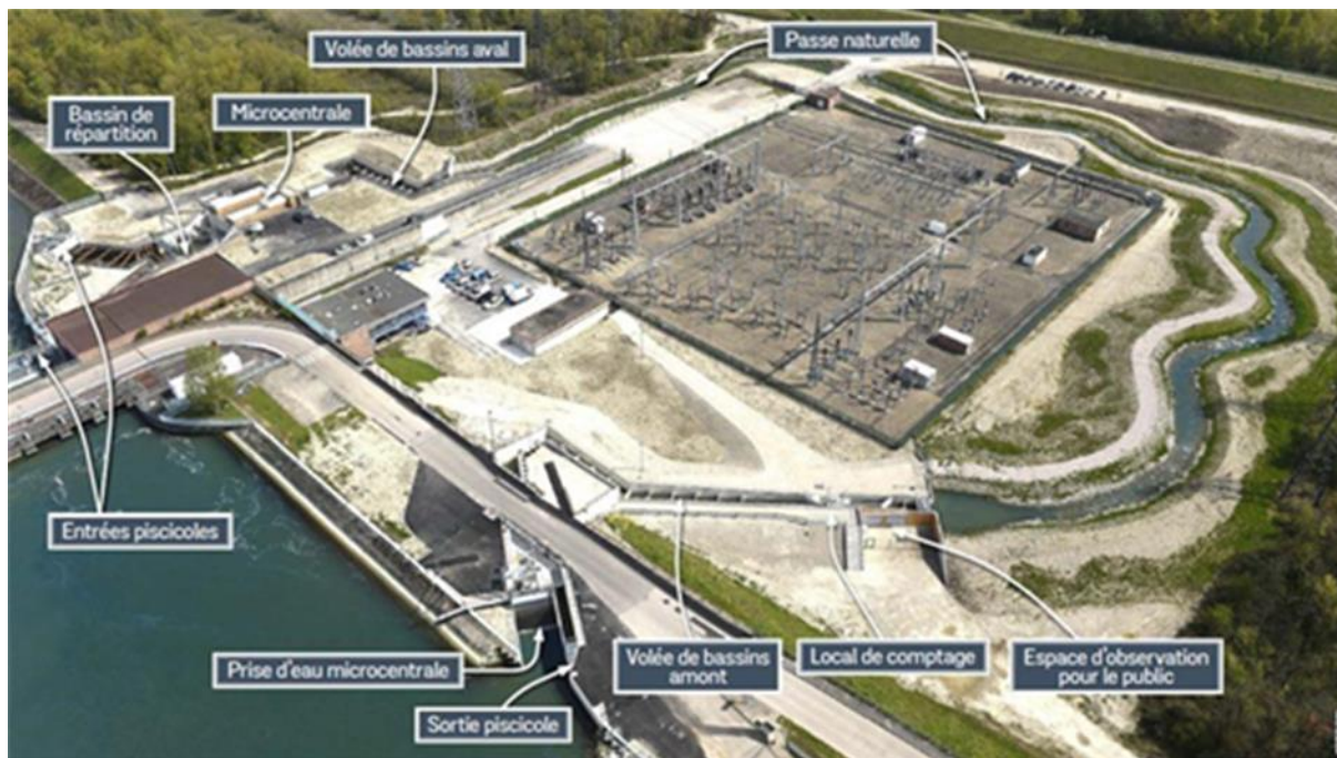
Figuur 21: Verschillende onderdelen van de vispassage in Straatsburg
